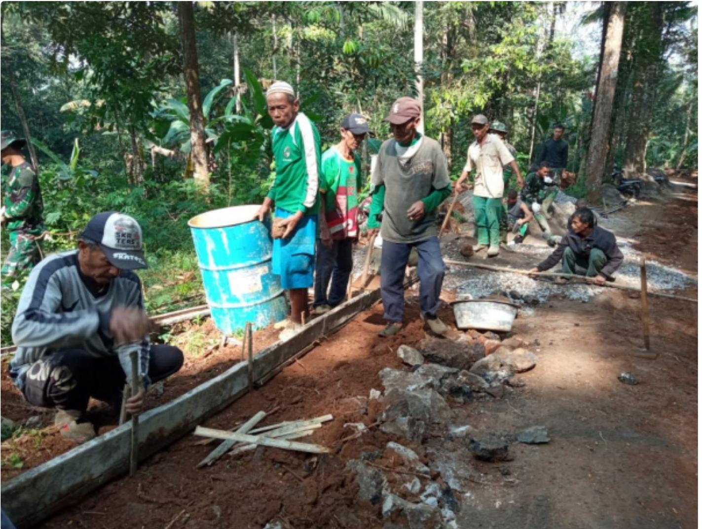
*Warga membuktikan dukungannya dalam bentuk nyata, dengan turun langsung membantu anggota Satgas TMMD mengerjakan cor rabat beton jalan.*
