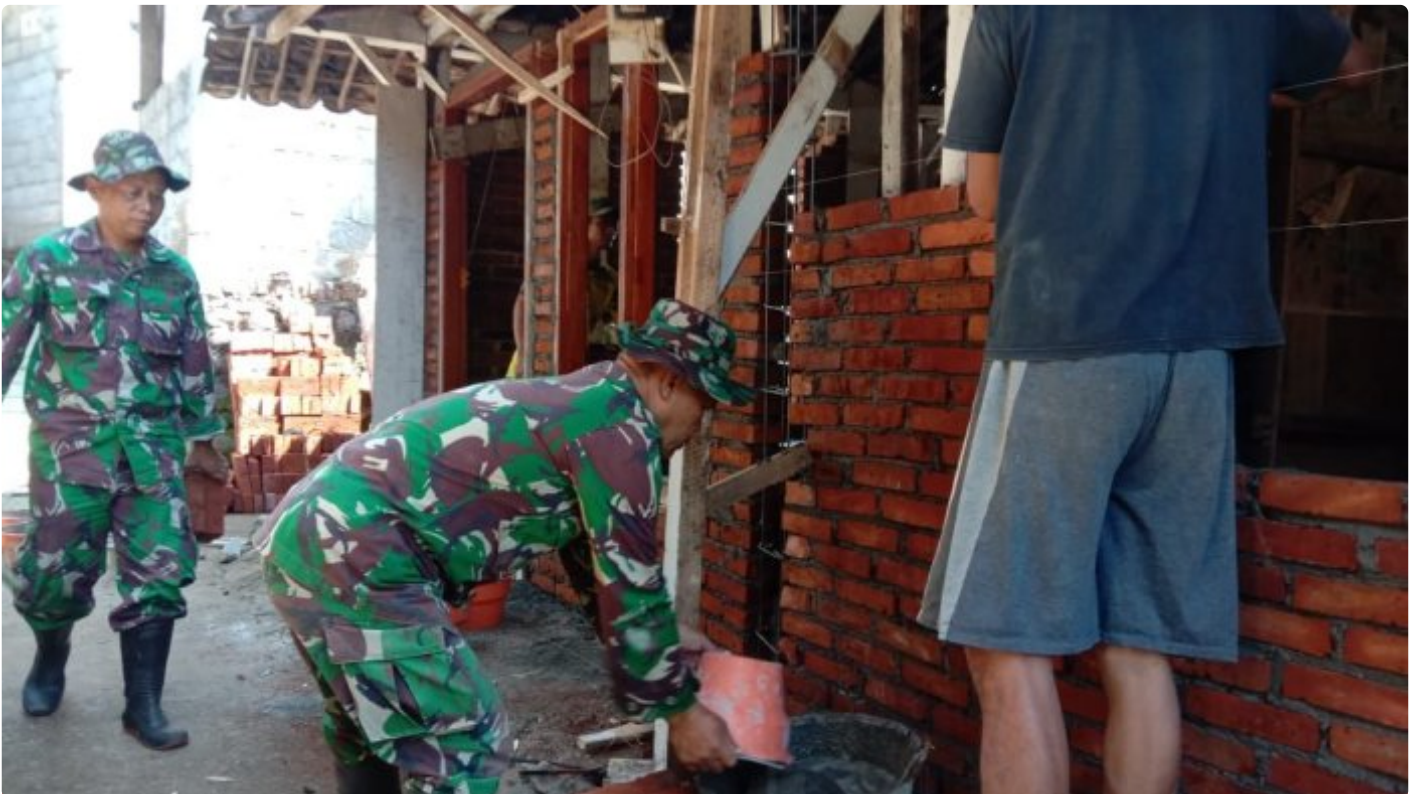
Satgas TMMD Sengkuyung Kerjakan RTLH Milik Bpk Muslih Warga Dusun Tanjungan Desa Kembangsari Kecamatan Kandangan Kabupaten Temanggung
